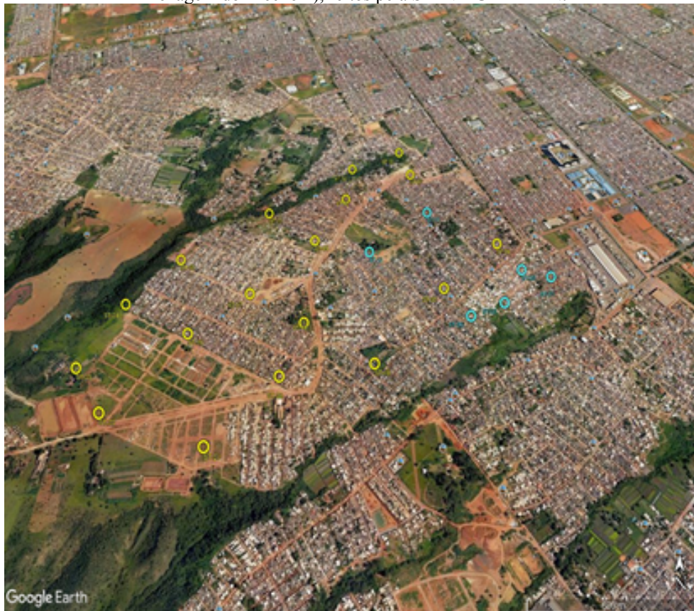
Figura 1.1.7 - Localização atual dos 6 pontos de Sondagem a Trado com presença de água (Rede de Drenagem do Trecho 2), feitos pela SAINT-GERMAIN.
